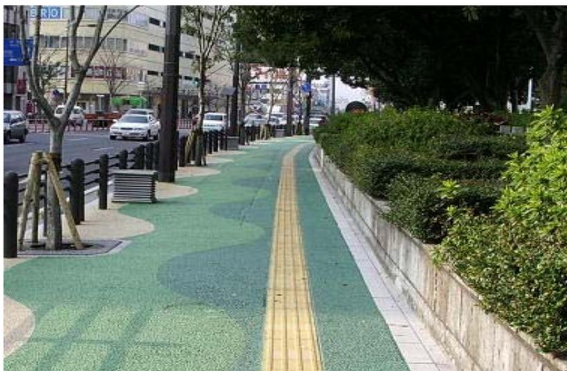
1) 開粒度アスコンのカラー化による温度上昇抑制効果:通常舗装(黒)に比べ、概ね青-3℃、緑-6℃、黄-9℃となっており、淡色の方が温度上昇抑制効果が大きくなっている。これは、日射蓄熱量の違いによるものと判断される。
